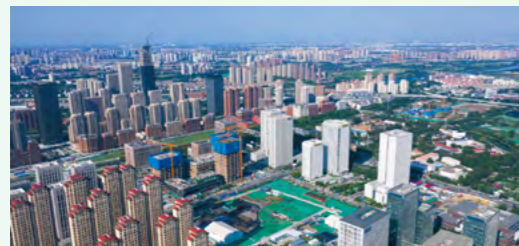
天津河西陈塘土壤修复项目 Tianjin Hexi Chentang Soil Remediation Project
