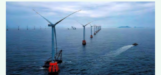
国内首个在强台风海域条件下施工的风电场——国电舟山普陀6号海上风电场2区工程
